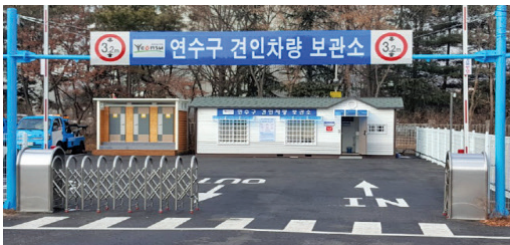
<불법 주정차 견인보관소 전경>
