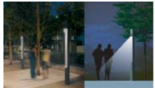
〈그림 4-22〉 보행자가 감소하는 심야 시간대에는 조광을 실시하여 조도를 낮추는 것으로 소비전력을 억제
